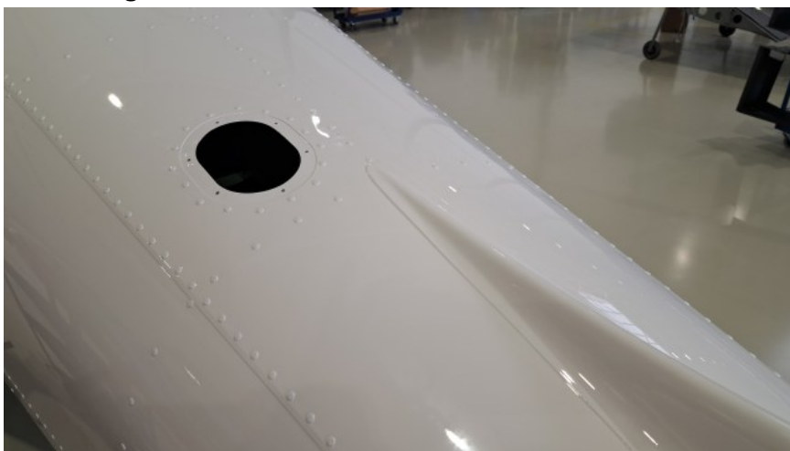
Obrázek 1 Kontrolní otvor (po odstranění krytu) na horní straně trupu. Tímto otvorem lze vizuálně zkontrolovat vnitřní konstrukci trupu, zda jsou instalovány všechny nýty.
